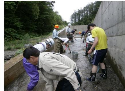
魚道の清掃は、ポキアッブ川の本流NO.1谷止工・NO.2魚道工、支流NO.1谷止工・NO.4魚道工の2ヵ所に分かれ行われました。胴付きや長靴を履いた参加者は、スコップを手に魚道内に溜まった土砂や石をかき出すなど、魚道の機能回復と魚の生息環境の維持に汗を流しました。
