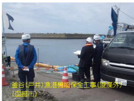
釜谷(戸井)漁港機能保全工事(駿浜外) (函館市)
